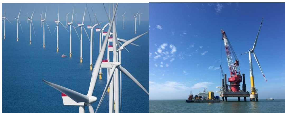
图 5 海上风力发电场及海上风力发电安装
